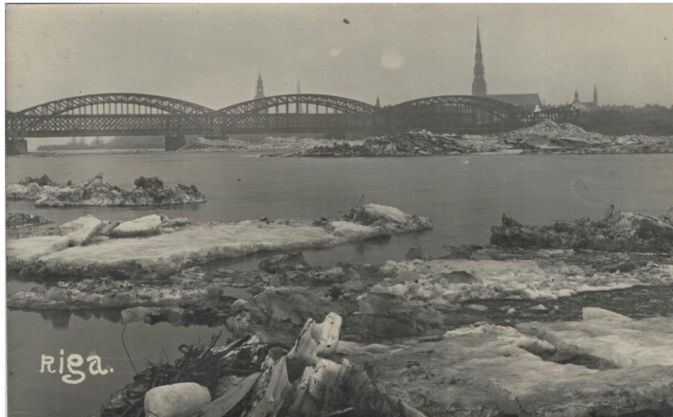
Bild 5 – Die Eisenbahnbrücke über die Düna
