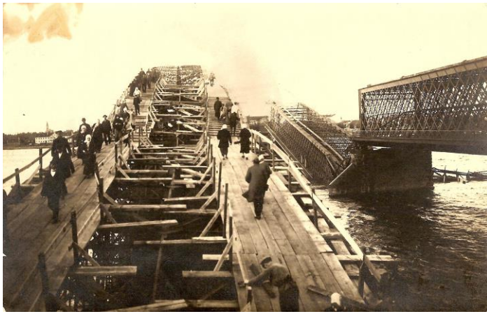
Bild 7 – Behelfsbrücke
